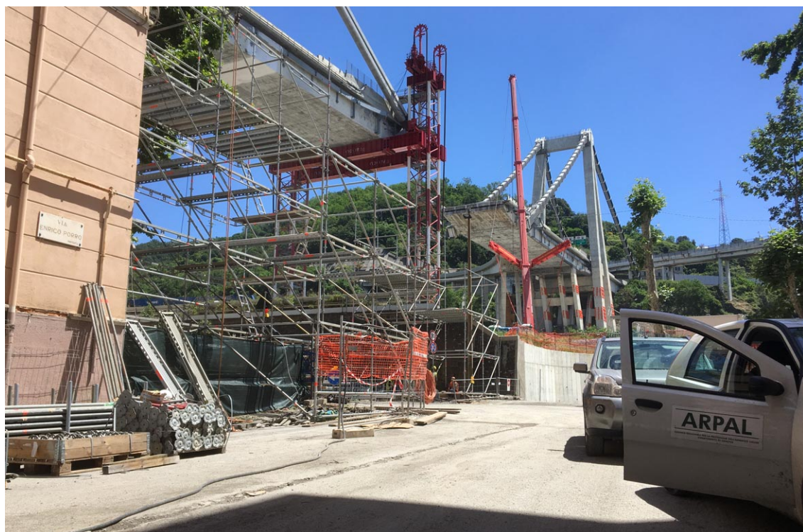
Figura 1: Sopralluogo ARPAL presso il cantiere della demolizione
